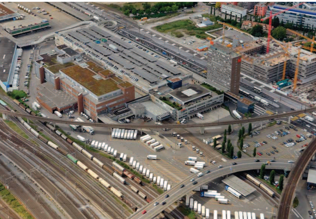
Der Standort der grössten Schweizer Tanzschule/Herdern Luftansicht © vision on wings Manfred Richter
